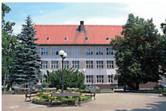
Oławski „Ogólniak” przy placu Zamkowym wkrótce będzie poddany termomodernizacji
