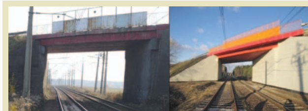
Tak wyglądał wiadukt przed remontem, a tak jest teraz
