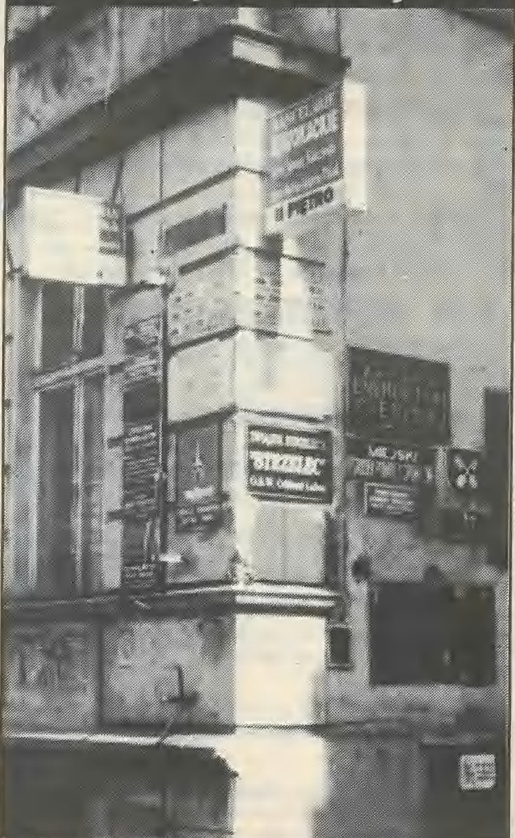
Coraz ciśnień robi się na lubańskich murach. Aż strach bierze, co to będzie, jak się jeszcze rozkręcimy. Swoją drogą, co na to lokalny architekt?
