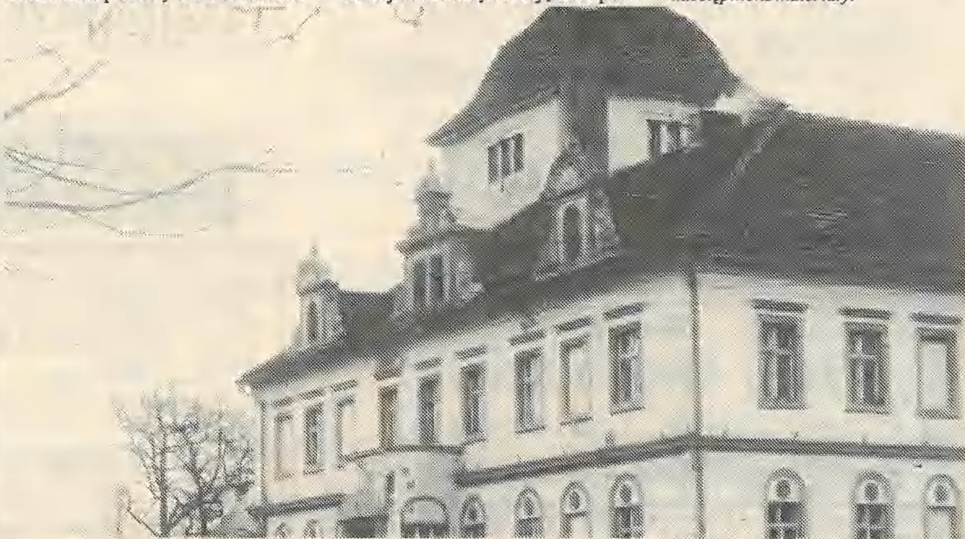
Olszyna Dolna Pałac - początek XIX w.
