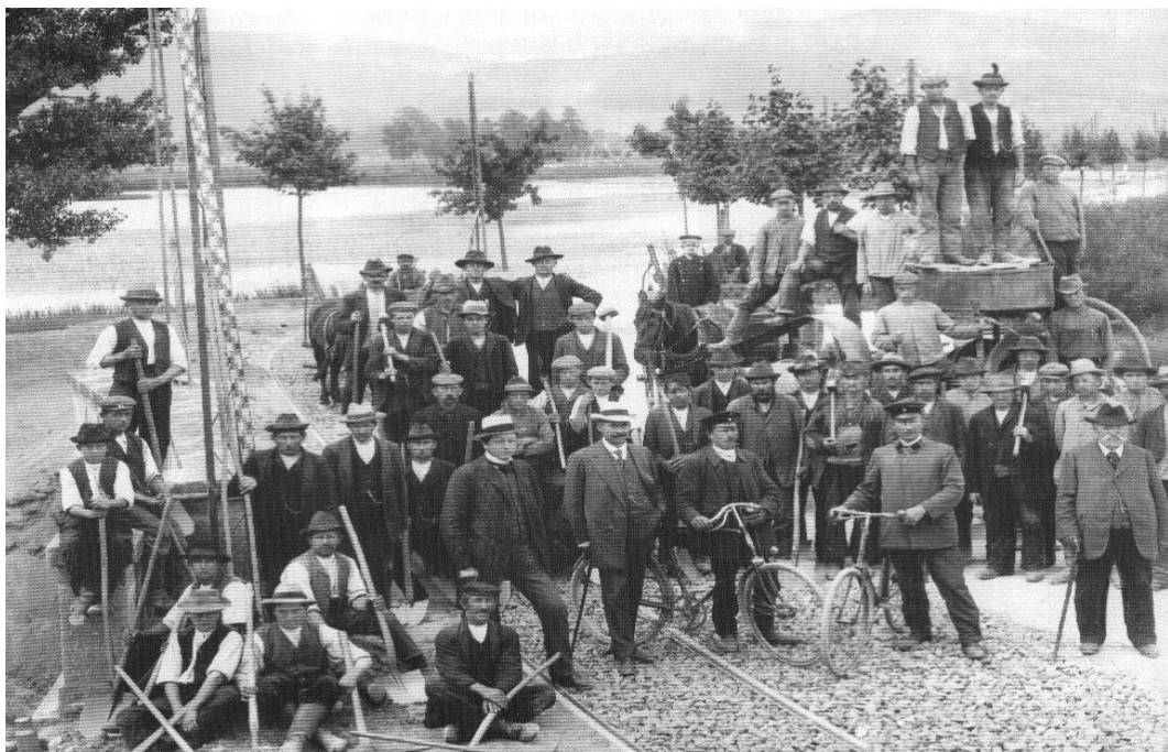
Fot.1. Budowa linii tramwajowej do Podgórzyzna. Lato 1911 rok. Fot. ze zbioru Henryka Magonia.
