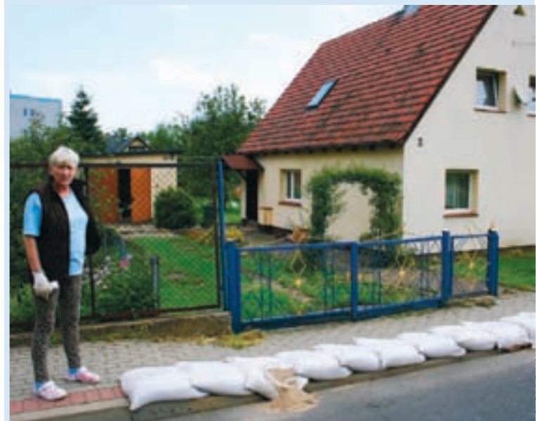
- Woda wdzierła się na moje podwórko z ulicy, na której są zasypane studzienki - mówi Teresa Dubowik.
