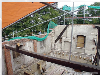
Remont pałacu w Pakoszowie
