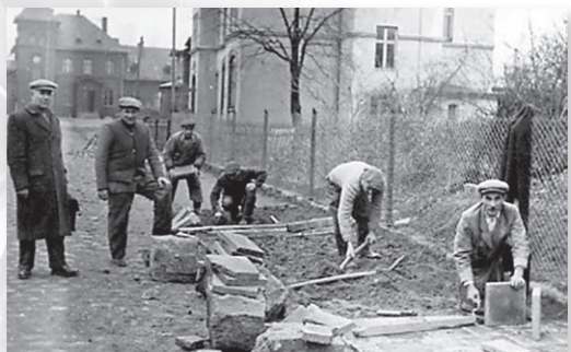
Nowe chodniki na ul. Mickiewicza, nadzoruje A. Fiedoruk
