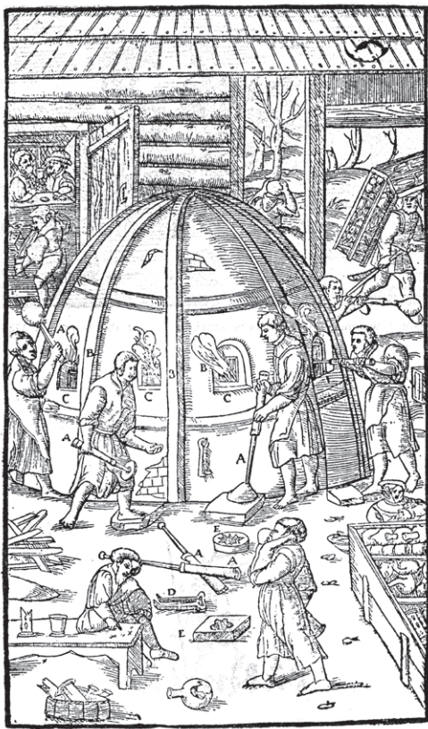
Wytop i obróbka szkła dawniej
