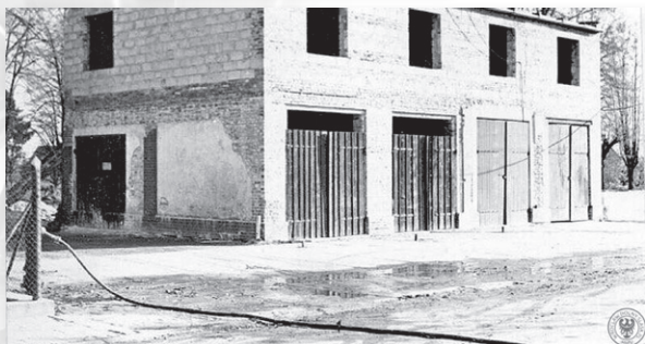
Dom Strażaka w budowie
