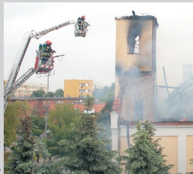
Kościół bez części wieży, budynek bez dachu
