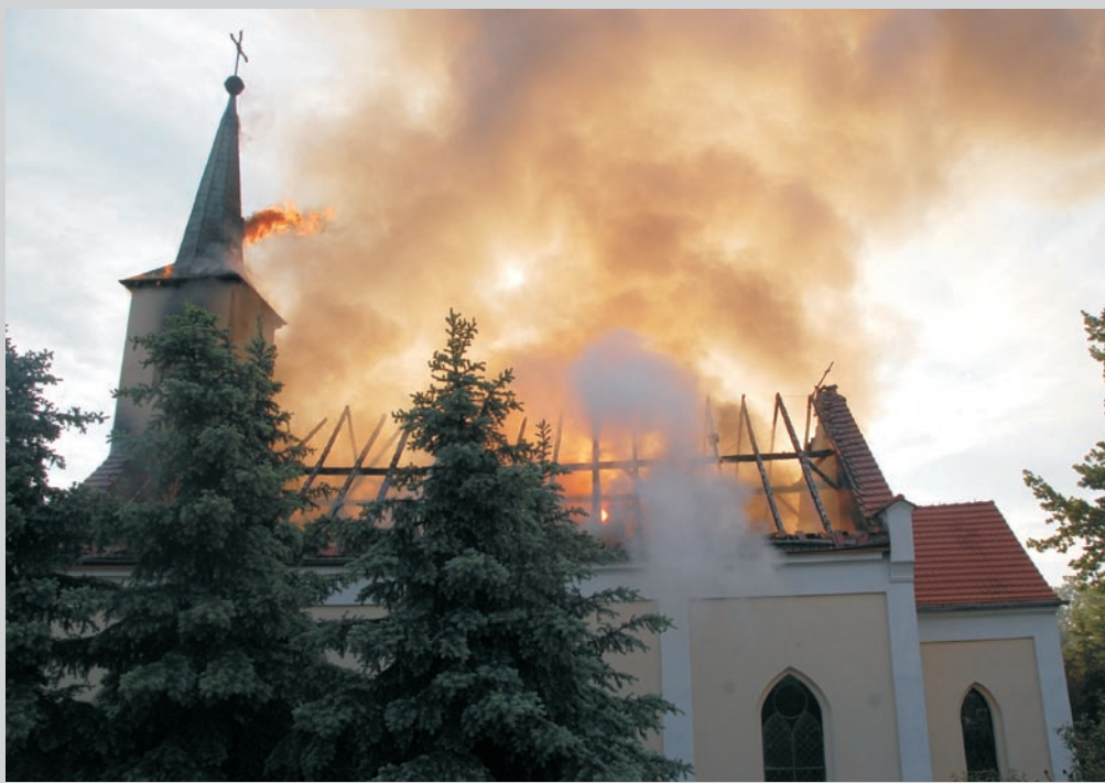
Płomienie opanowały kościół i dach sąsiedniego budynku
