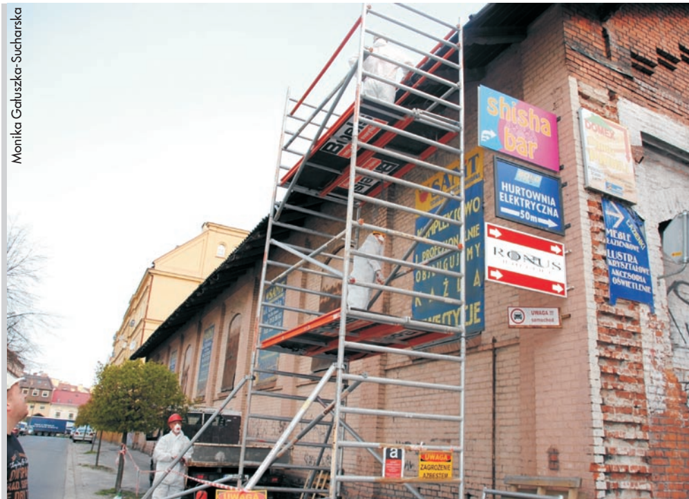
Niedawno usuwano azbest z budynku przy ulicy Młyńskiej w Olawie
