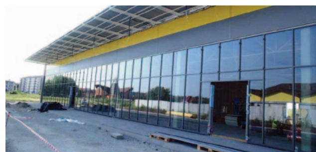
Obiekt jest już prawie gotowy
