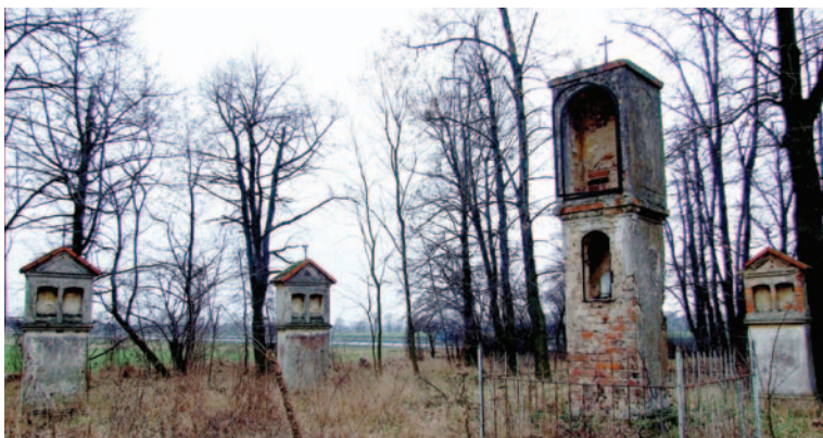
Zniszczona droga krzyżowa w Oleśnicy Małej ciągle czeka na renowację
