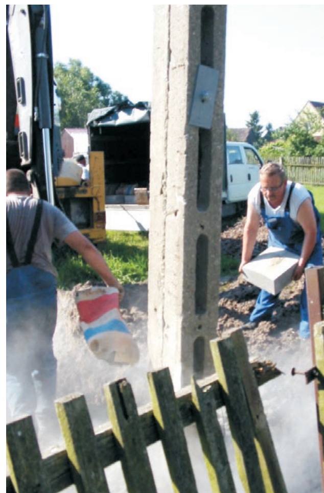
Osadzanie nowego słupa z platformą
