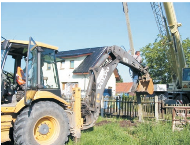
Przy pomocy dźwigu i koparki usunięto uszkodzony słup
