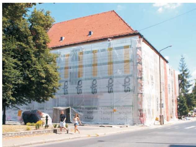
Trwa termomodernizacja budynku oławskiego „Ogólniaka” przy placu Zamkowym
