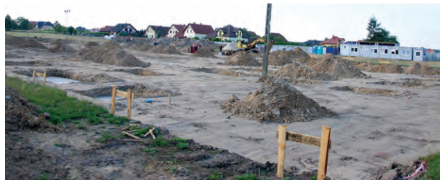
Prace budowlane trwają
