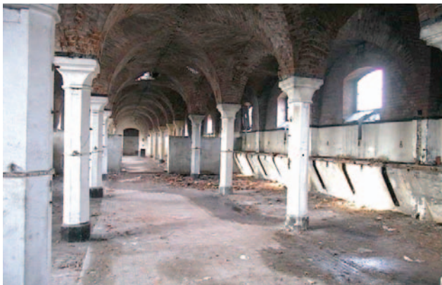
Wnętrze obiektu przy ul. 3 Maja wymagające przebudowy
