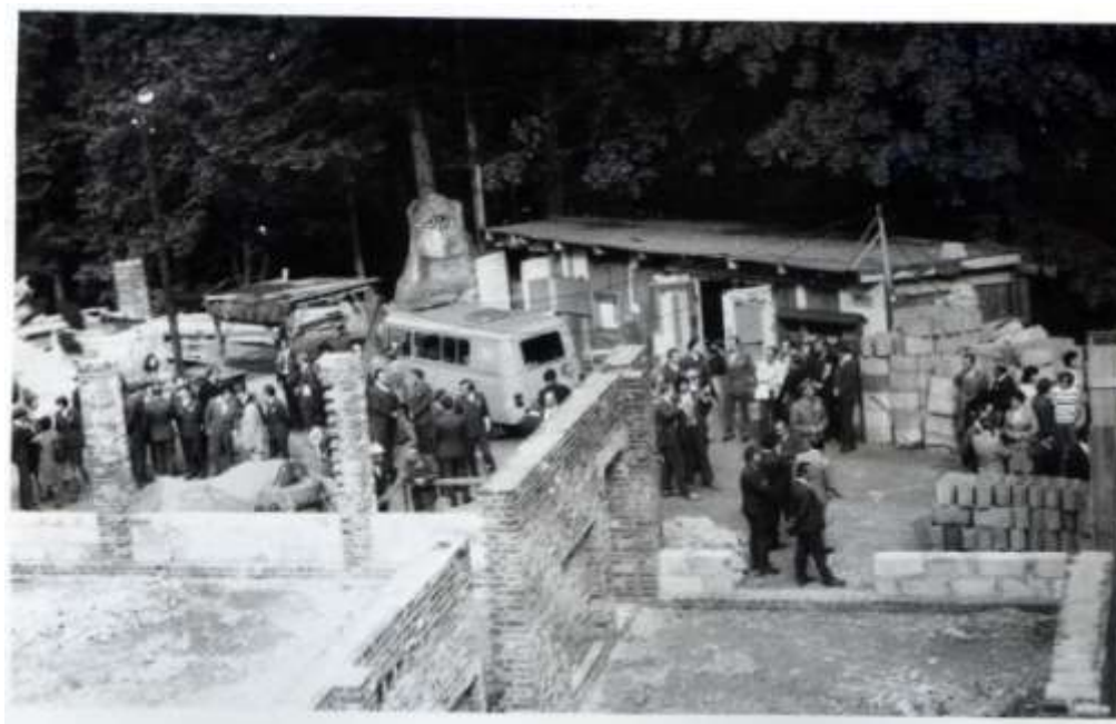
Teren budowy hotelu w pierwszych dniach „Akcji Hotel”
