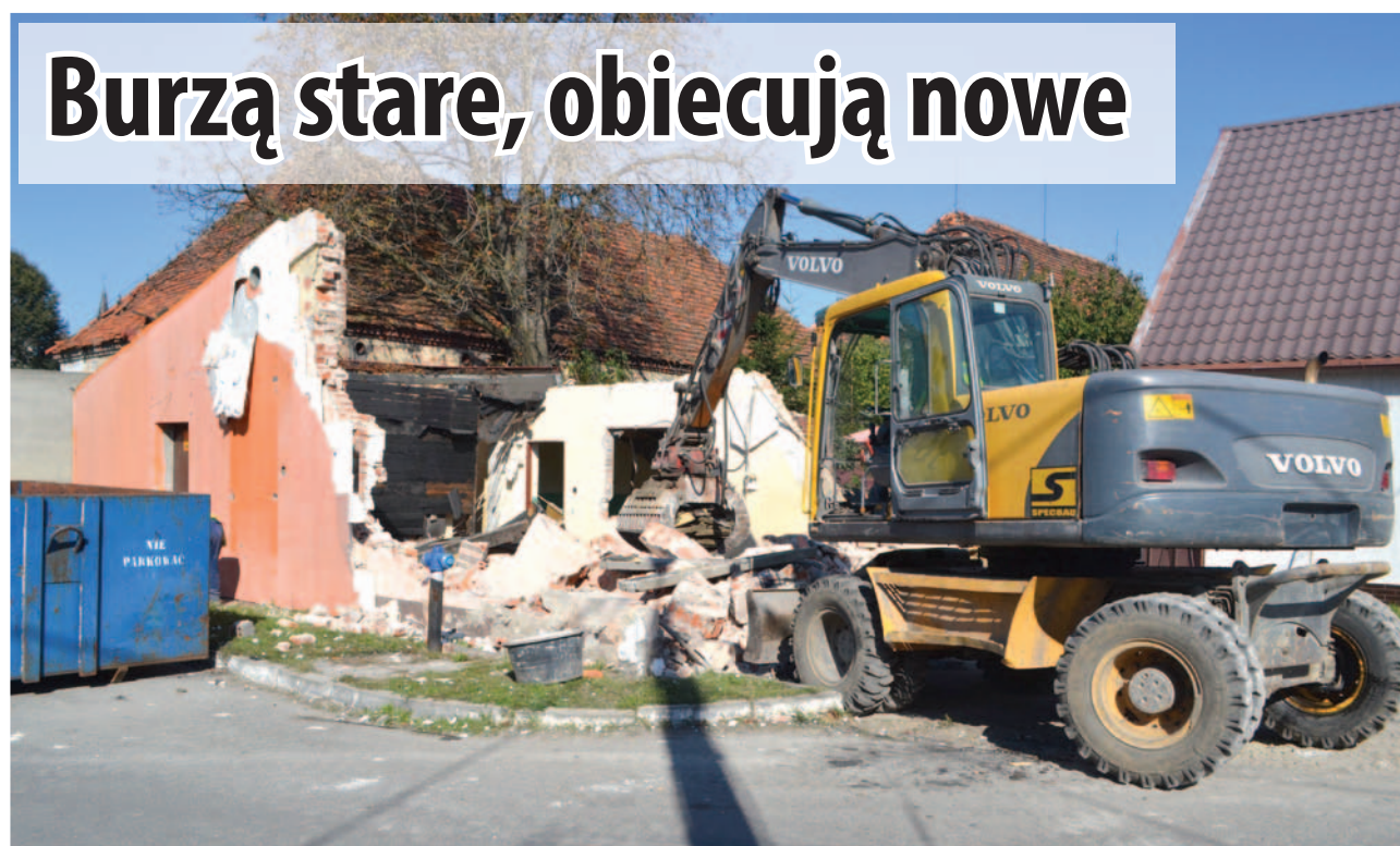
Wyburzana jest też remiza Ochotniczej Straży Pożarnej w Jelczu-Laskowicach, którą kilka lat temu zamknięto, na wniosek powiatowego inspektora nadzoru budowlanego
