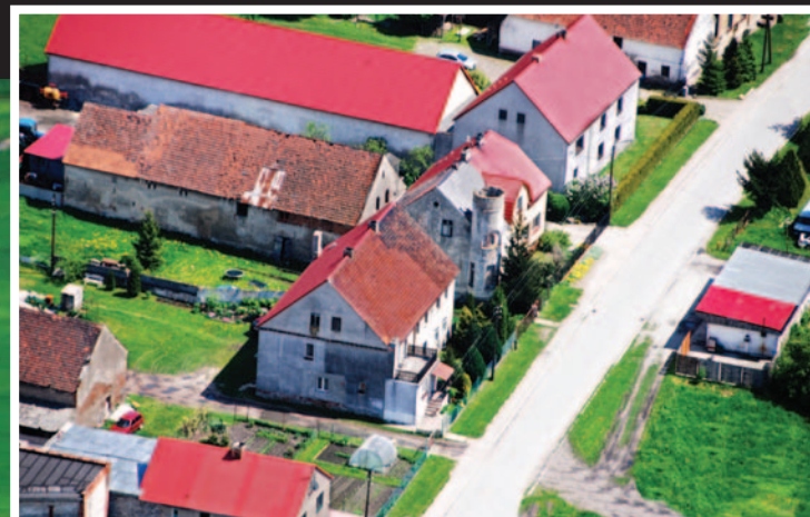
Rzucający się w oczy budynek z wieżą niedaleko sklepu
