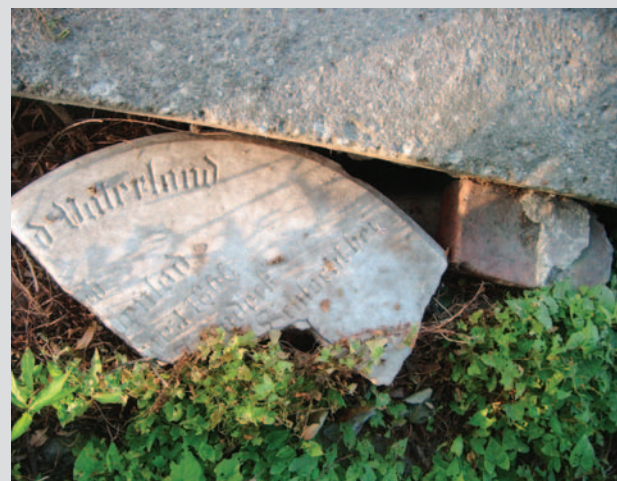
Fragment płyty nagrobnej użytej na zabezpieczenie dziury
