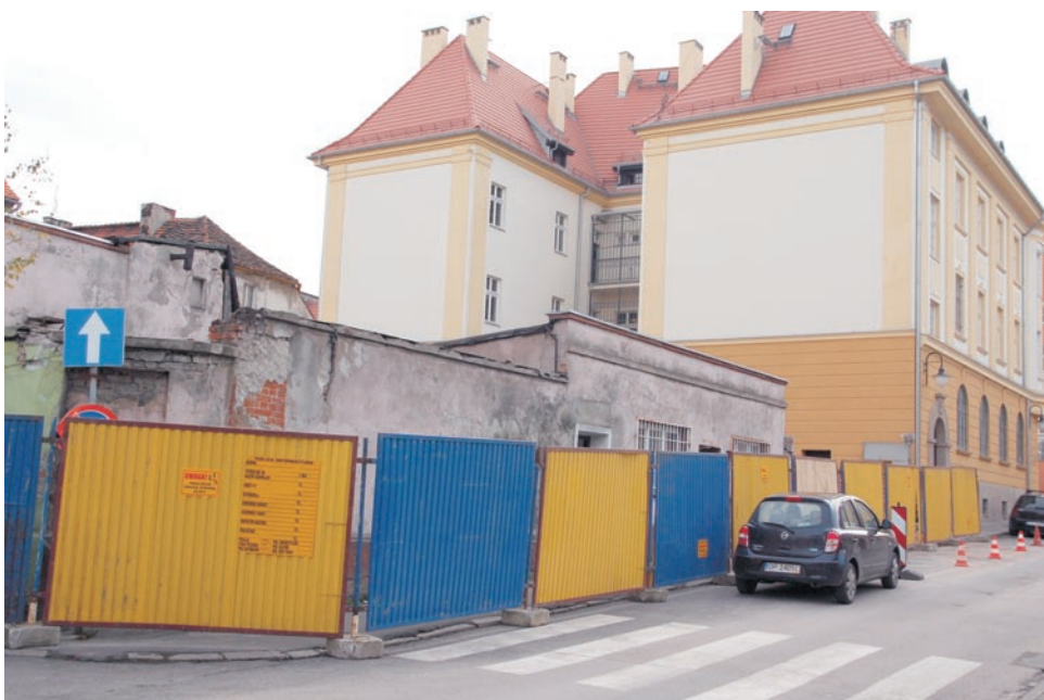
Rozpoczęła się modernizacja i przebudowa oławskiej komendy policji
