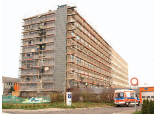
Trwają zaawansowane prace przy termomodernizacji olawskiego szpitala
