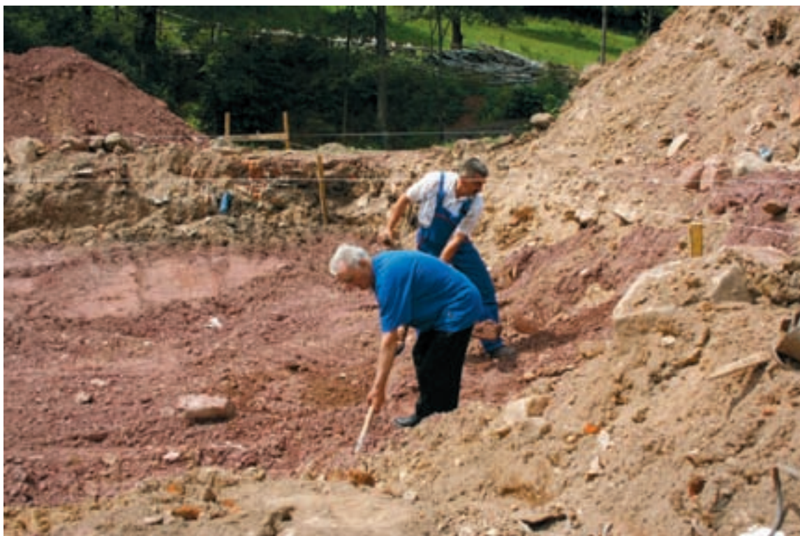
Dobków, odbudowa: Jest jednak nadzieja, że dom uda się odbudować.
