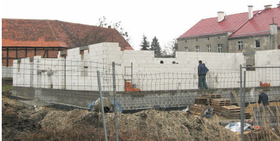
Powstający na osiedlu Zwierzyniec Duży budynek socjalny ma być oddany do użytku w IV kwartale tego roku
