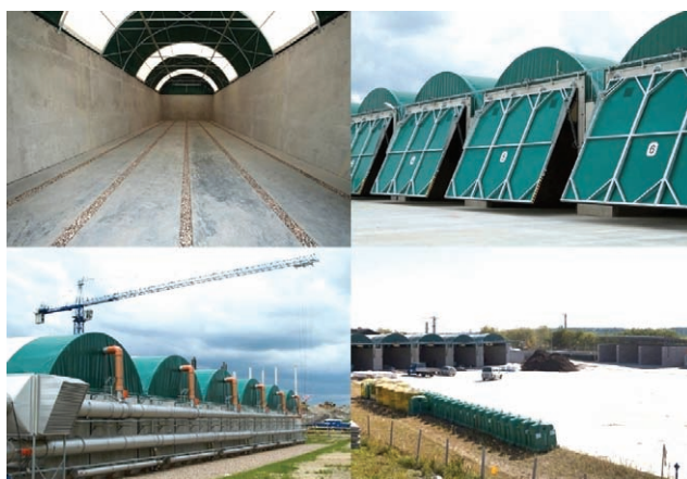
Po zakończeniu projektu Zakład Gospodarowania Odpadami w Gaci będzie jednym z najnowocześniejszych w Polsce. Na fot. ukończona inwestycja do stabilizacji tlenowej
