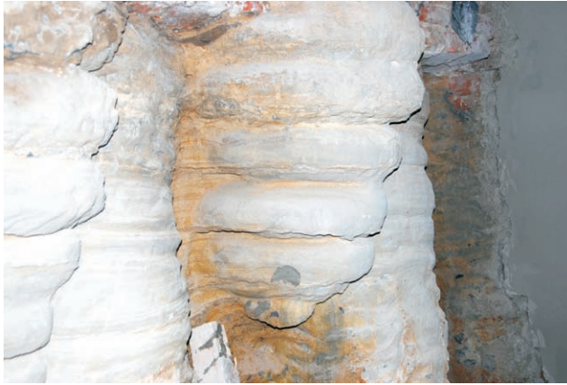
Fundamenty wzmocniono betonem
