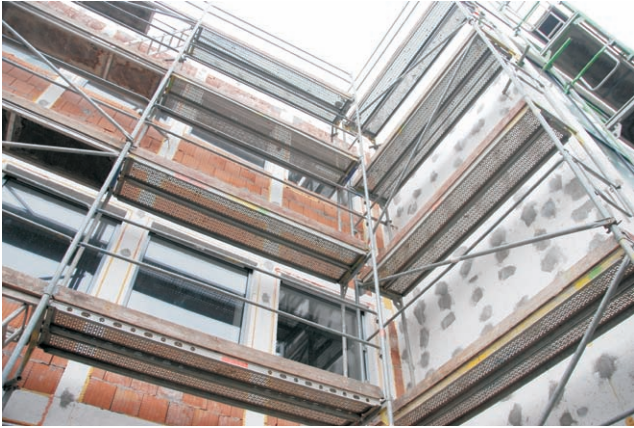
Budynek od podwórka
