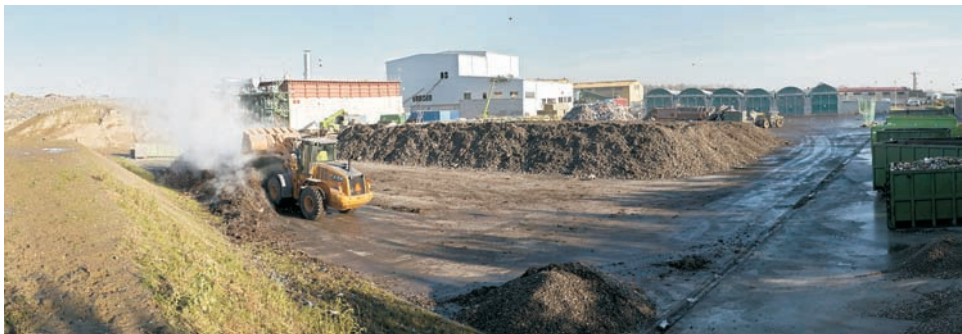
ZGO w Gaci - część biologiczna
