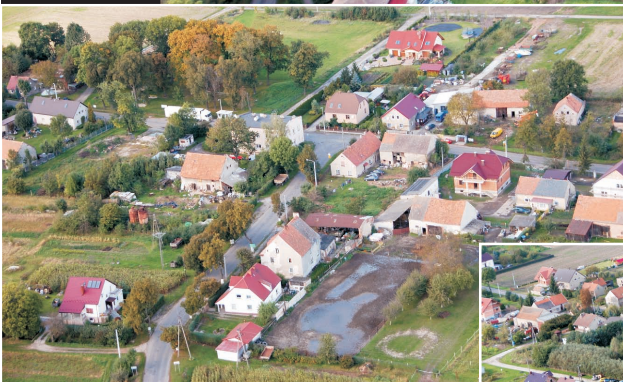
Zbliżenie na skrzyżowanie w centrum Piskorzówka
