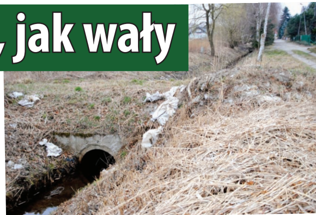
Przy rowie na ul. Klonowej worki z piaskiem leżą od powodzi w roku 2010
