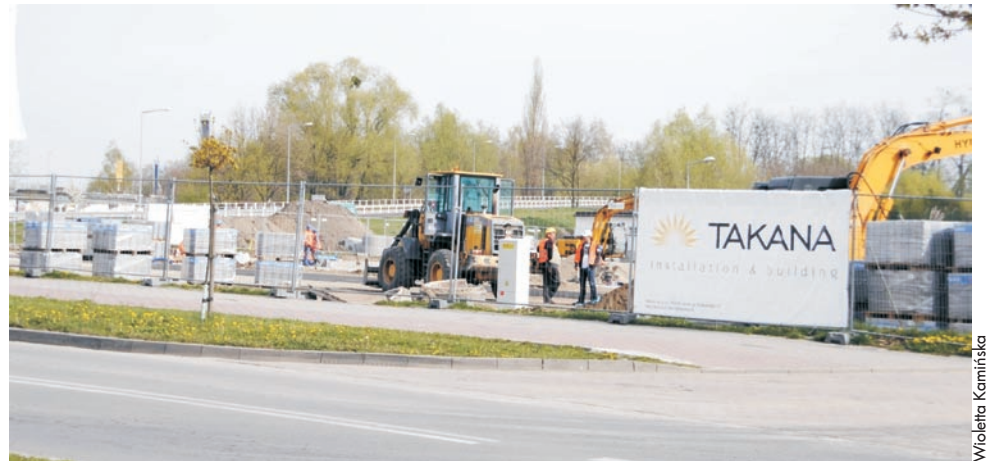
Na działce obok Bricomarche powstaje parking i fragment obwodnicy Hirszfelda
