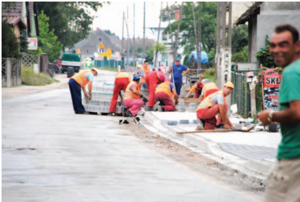
Remont drogi powiatowej przez Bystrzycę rozpoczęto od budowy chodników
