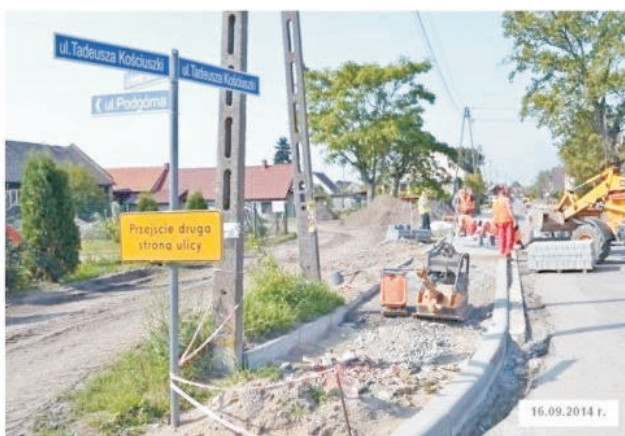
Budowa drogi w Bystrzycy
