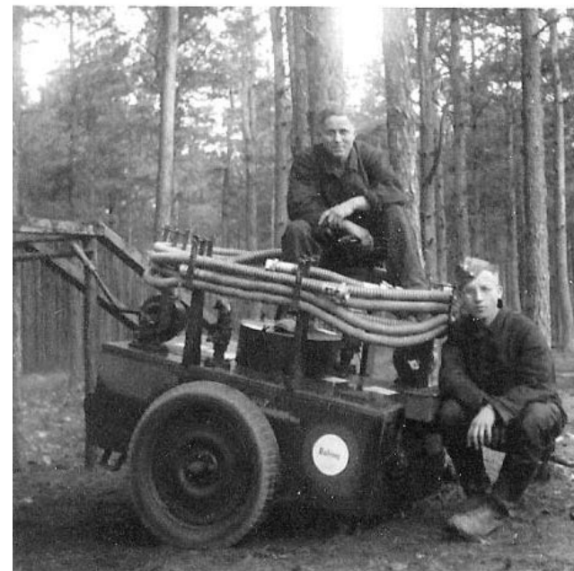
Przyczepa A1 - wersja ze zbiornikiem i pompą ręczną
