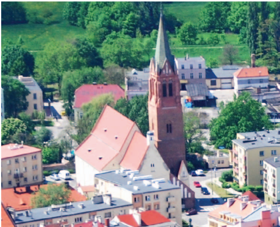
Pracownicy dawno zakończyli prace na dachu, ale rozliczenia trwają już ósmy rok
