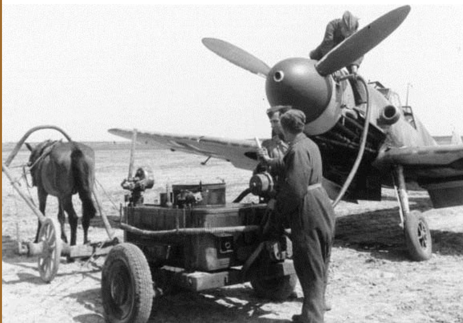
Wymiana oleju w myśliwskim samolocie Messerschmitt BF-109, zestaw pomp na przyczepie A1, takiej jak ta z Marcinkowic. Zdjęcie wykonane na lotnisku polowym w Rosji, 1942 rok
