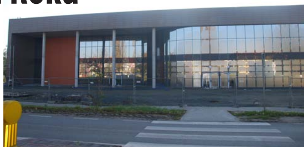
To już ostatnie miesiące budowy hali
