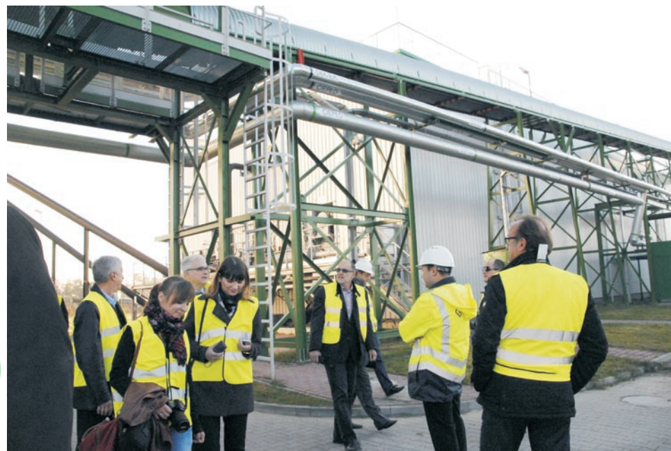
To jedyna w Polsce instalacja do mechaniczno-biologicznego przetwarzania bioodpadów, z których pozyskiwana jest energia elektryczna i ciepła
