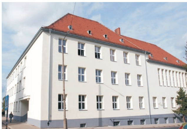
Budynek LO nr 1 im. Jana III Sobieskiego po termomodernizacji
