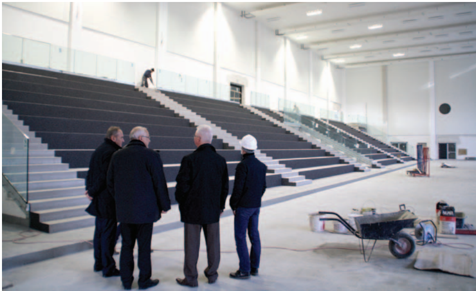
W hali sportowej trwają obecnie prace wykończeniowe
