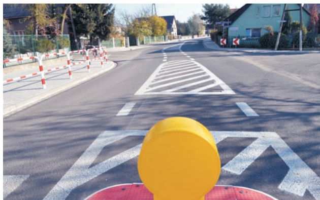
Zmodernizowana droga powiatowa nr 1549D, przebiegająca przez Bystrycę
