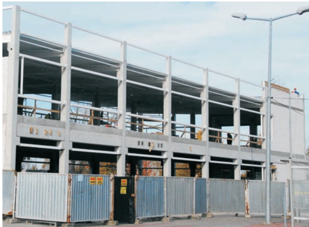
Nowy biurowiec w budowie
