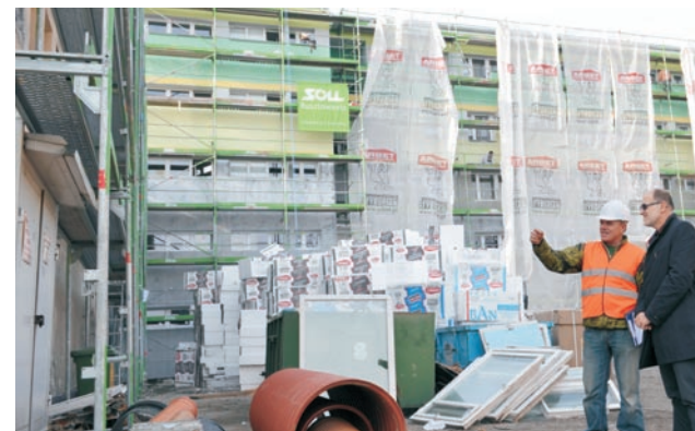
Dobiega końca modernizacja budynku dawnego internatu, przy ul. Kutrowskiego w Oławie
