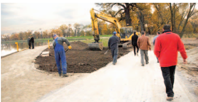
Dzień przed odbiorem - 5 października - nowe wały przeciwpowodziowe kolejny raz kontrolowała komisja ds. Zabezpieczenia Przeciwpowodziowego, działająca przy RM w Jelczu-Laskowicach
