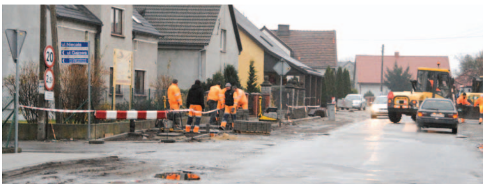
Budowa ostatniego odcinka chodnika zakończyła się tydzień temu
