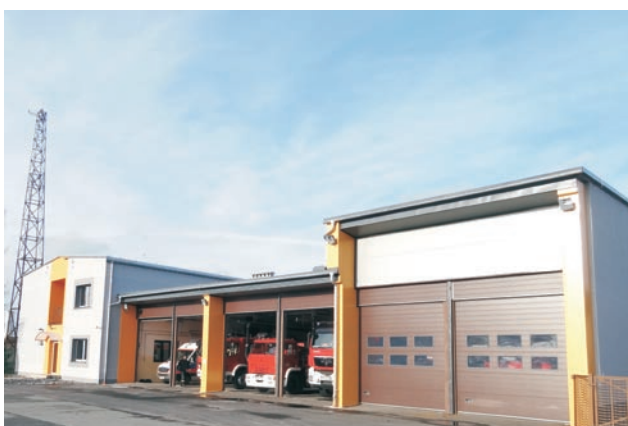
Strażnica Jednostki Ratowniczo-Gaśniczej w Jelczu-Laskowicach po termomodernizacji
