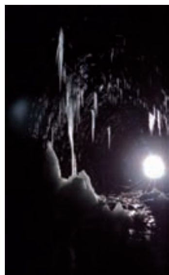
Wyróżnienie: Tomasz Ujma - W tunelu mróz, tunel kolejowy w Kowarach, styczeń 2014.
