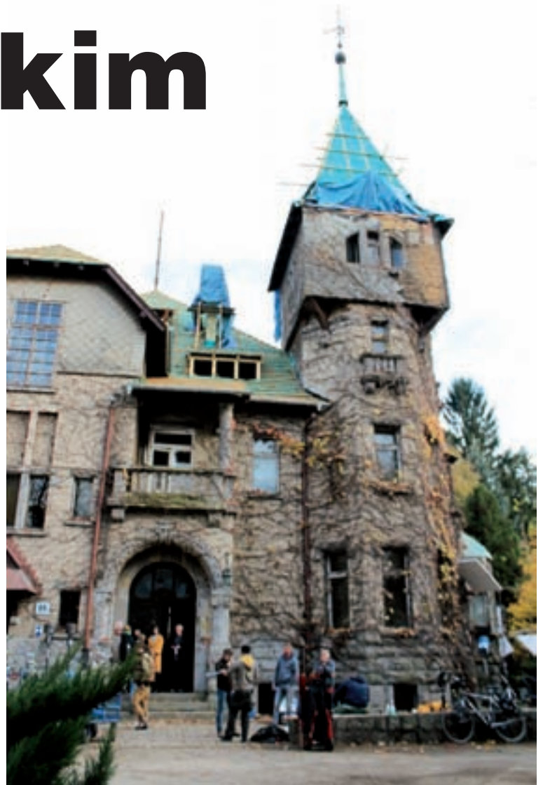
Czekająca na remont budowla zachwyciła ekipę filmową.
