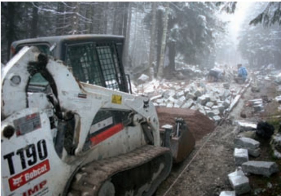
Prace na drodze do schroniska Samotnia trwają w najlepsze. Nie widać, aby był realizowany plan przywrócenia „właściwości jezdnych” ulicy, co obiecywała dyrekcja KPN.
