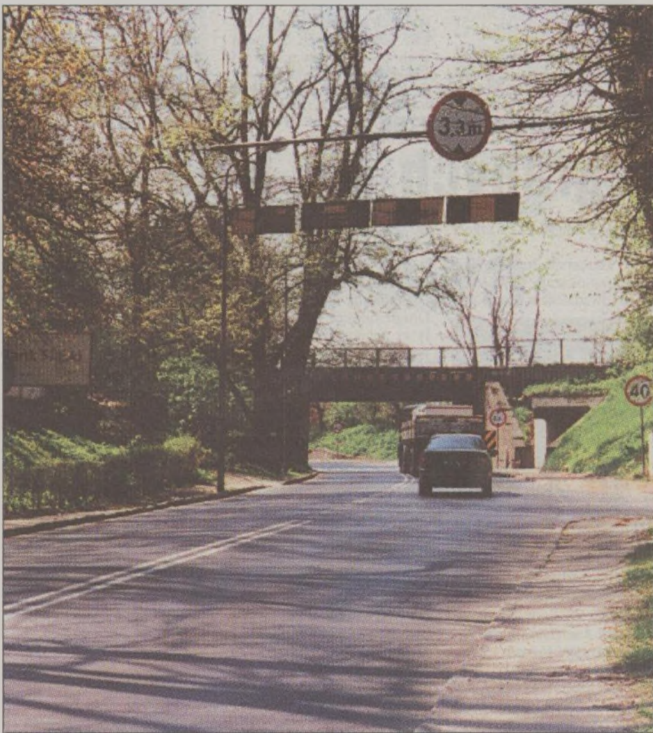
Przed wiaduktem zawieszono ograniczniki wysokości, w które kierowca wyższego samochodu powinien uderzyć. W hałasie drogowym uderzenia może jednak nie usłyszeć i wjechać pod wiadukt.
