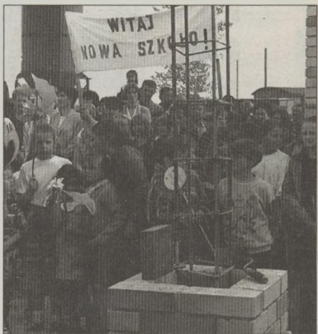
3 maja br. odbyła się w nowej szkole w Urazie uroczystość wmurowania kamienia węgielnego. Po uzyskaniu dotacji z BS nie będzie problemów z zakończeniem inwestycji.
