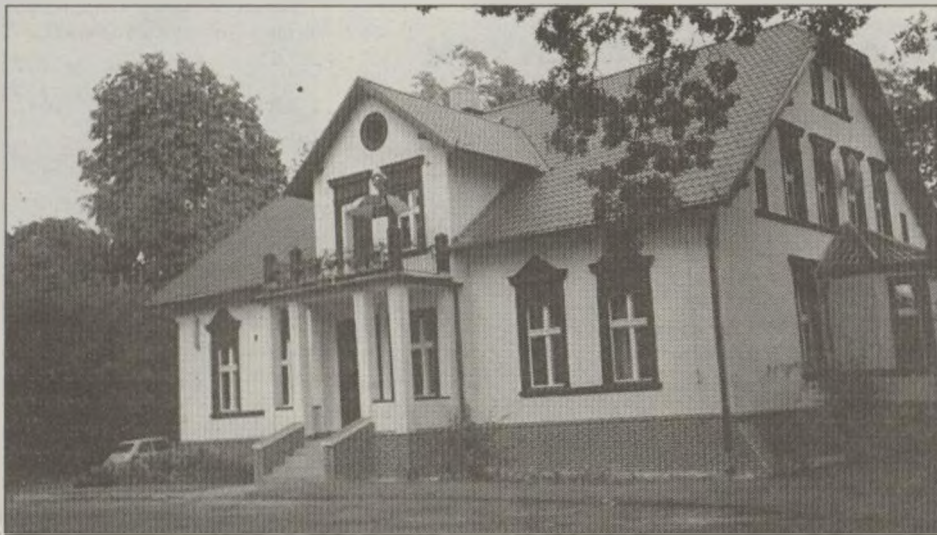
Dopiero po półrocznym remoncie udało się przystosować budynek po byłej szkole do nowej funkcji.
