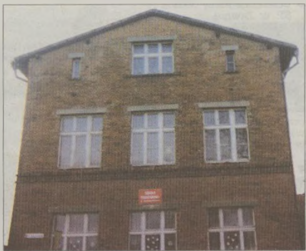
Budynek Szkoły Podstawowej w Rościslawicach.
