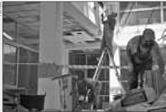
Prace wykończeniowe przy budynku dawnych koszar nabierają tempa.
