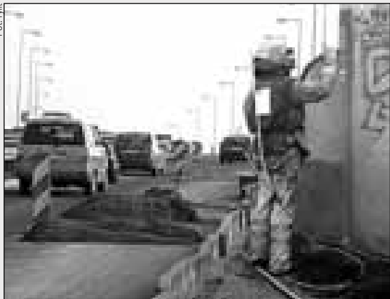
Ekipy wzmacniają konstrukcję chodników. Jest ona także czyszczona przez piaskowanie
