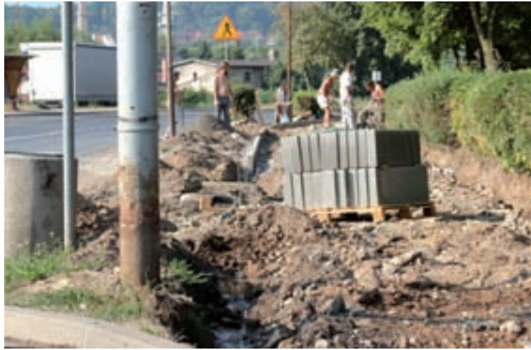
Remont ciągu pieszo-rowerowego przedłuża się.
