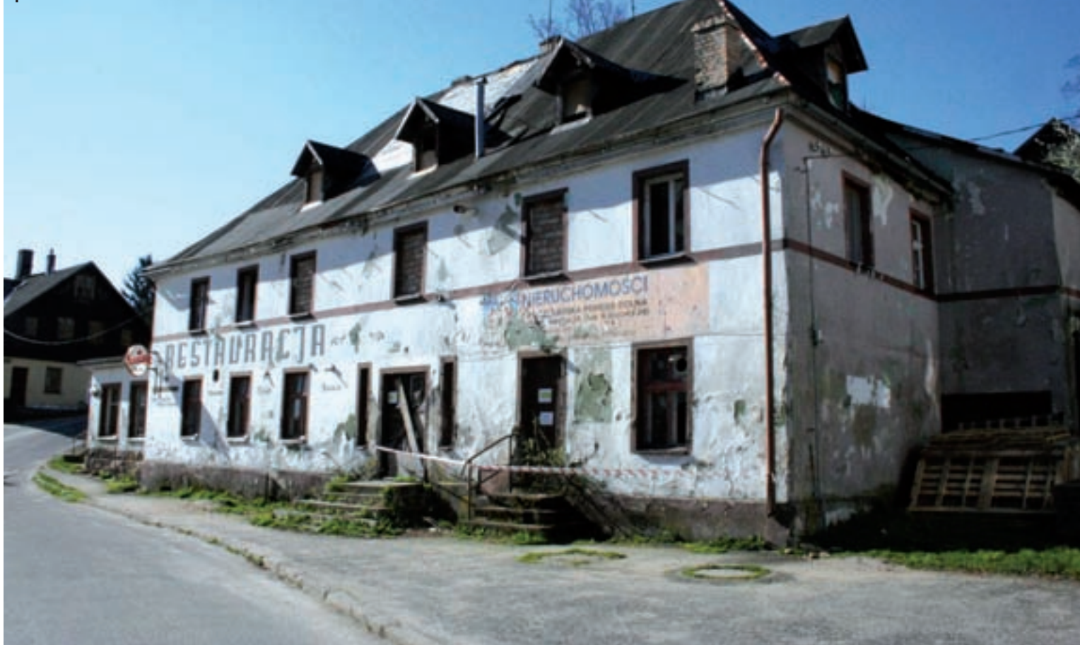
Restauracja „Jelonek” w budynku przy ul. Piastowskiej 24 w Szklarskiej Porębie działała do 2005 r. Potem nastąpiły zalania oraz włamanie, które uniemożliwiły właścicielce prowadzenie działalności
