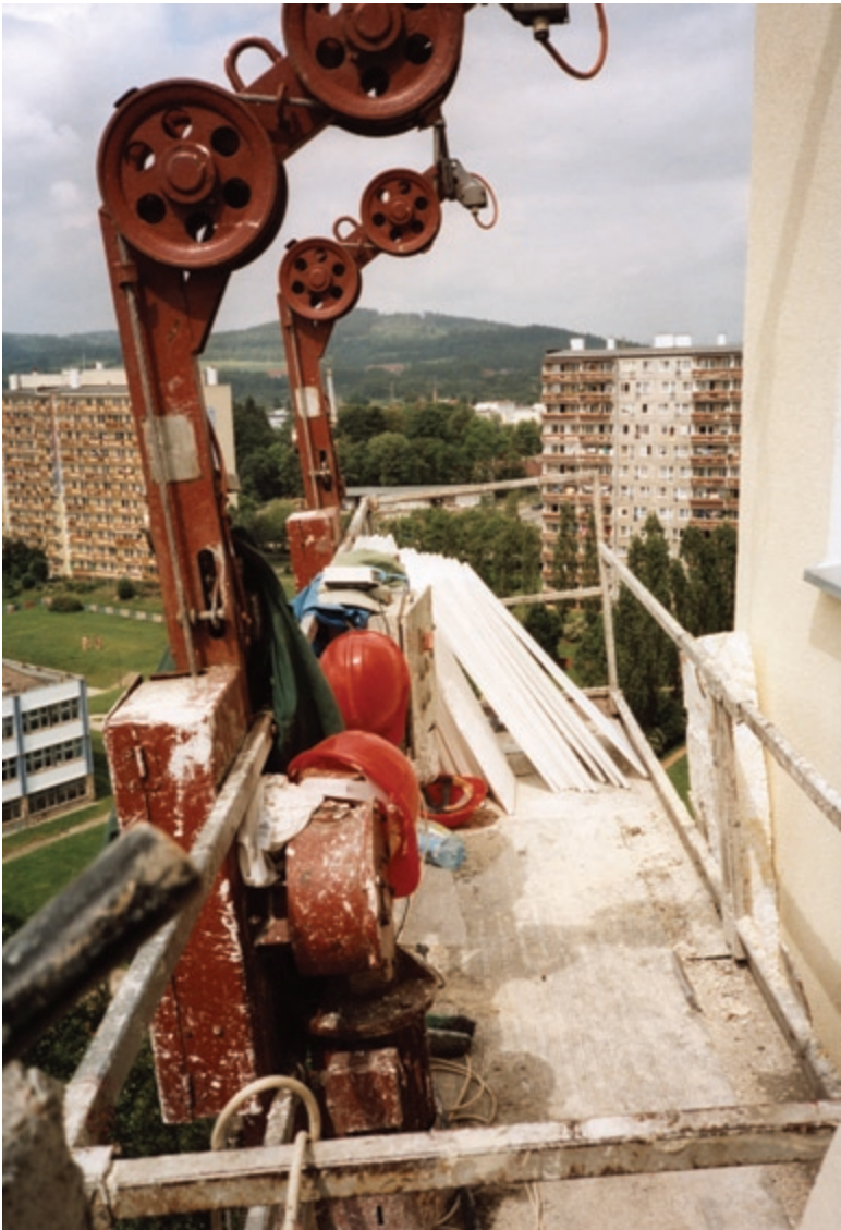
Na Zabobrze mieszkań spółdzielczych od dawna się nie buduje, ale osiedle jest ciągle placem budowy – dróg, sklepów, robót kanalizacyjnych lub ocieplających budynki
