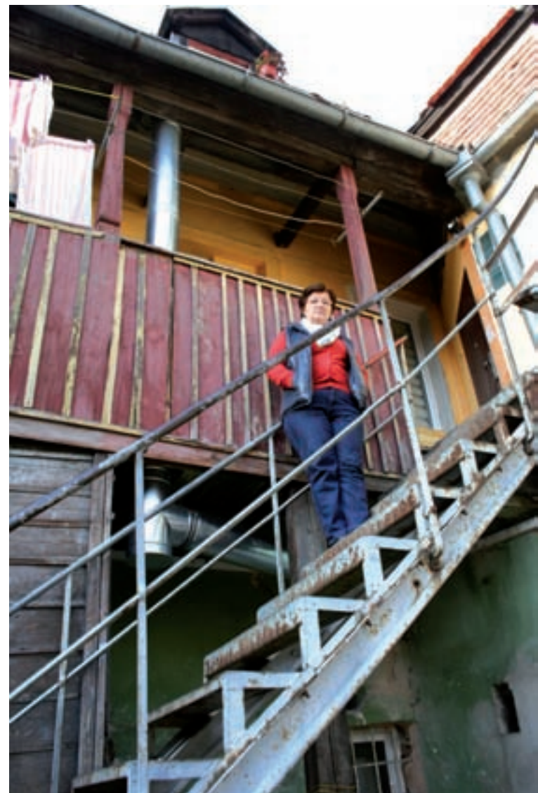
Maria Serafinowicz, zajmująca z partnerem lokal nr 7 przy Ogrodowej 53 w Kowarach, uważa, że przebijanie przewodem wentylacyjnym balkonu i dachu w ich zaniedbanym budynku komunalnym to zły i niebezpieczny pomysł.
