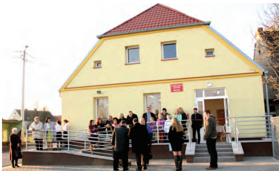
Do świetlicy dobudowano podjazd dla niepełnosprawnych
