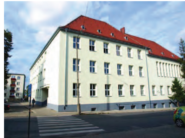
Budynek oławskiej „Alma Mater” w wyniku termomodernizacji uzyskał niedawno nową zewnętrzną szatę
