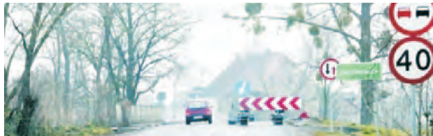
Most na drodze między Jaczkowicami a Godzikowicami już ponad rok jest częściowo zamknięty, a terminu remontu wciąż nie ma
