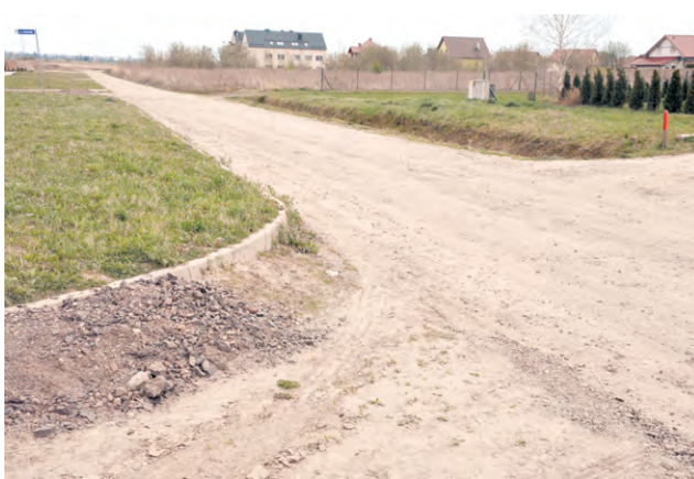
Tak wyglądają drogi na osiedlu
